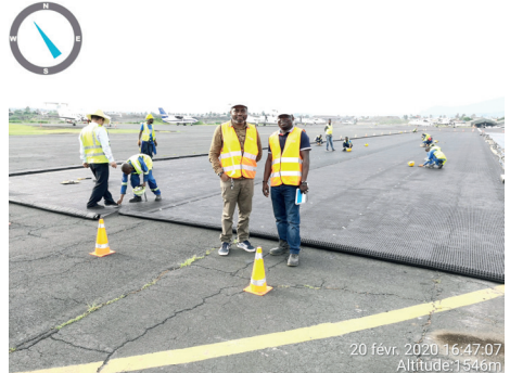
Benjamin à l'aéroport de Goma, travaux de réfection du tarmac
